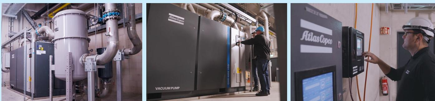
Il controller centrale Atlas Copco ES16 può monitorare e controllare più pompe per vuoto GHS VSD+ contemporaneamente. Il sistema di controllo intelligente bilancia e ottimizza le prestazioni di tutte le macchine, riducendo il consumo energetico complessivo.
