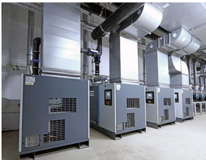
Pompe per vuoto a vite con guarnizione a olio GHS VSD+ Atlas Copco
