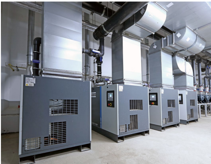
Ölgedichtete Schraubenvakuumpumpen GHS VSD + von Atlas Copco
